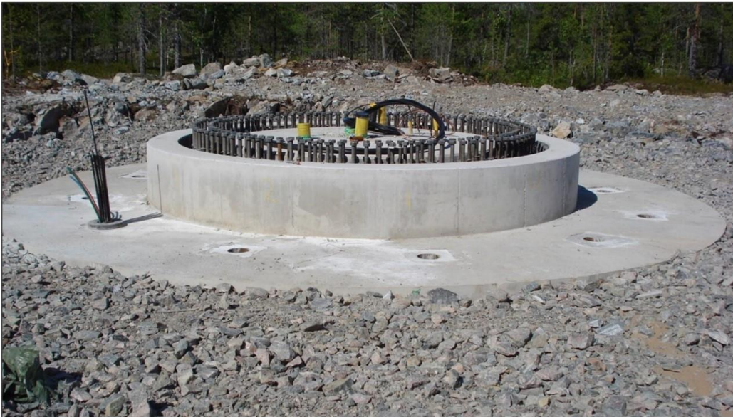
Kuva 8. Tyypillinen tuulivoimalan kallioankkuroitu teräsbetoniperustus. (Kuva: YIT)
