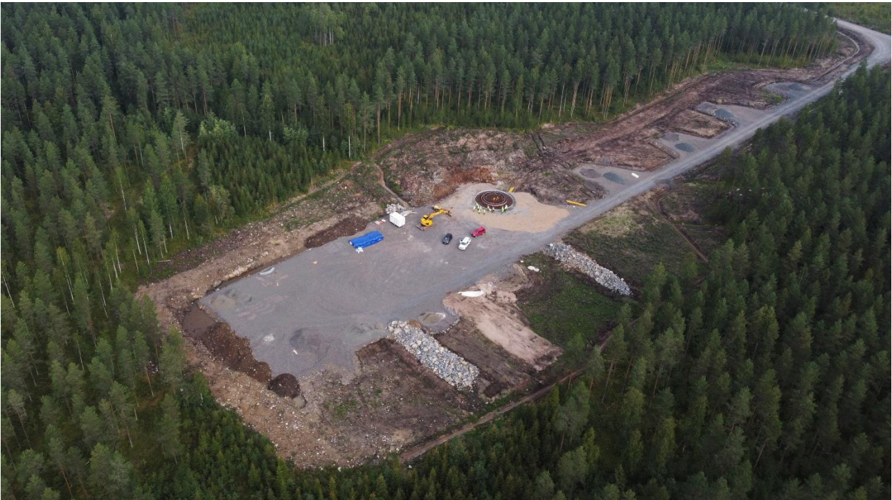
Kuva 14. Esimerkki tuulivoimalalle rakennetusta kokoamis- ja pystytysalueesta sekä voimalan perustuksista. Kuva: Eolus Energy Oy.
